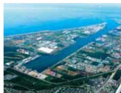
苫小牧西部工业基地 苫小牧西部工業基地
