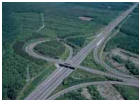
苫小牧东 IC 苫小牧東インターチェンジ
