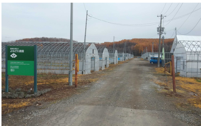
写真 ハウス団地
