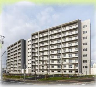
道営住宅 (旭川市であえーる宮下東)
