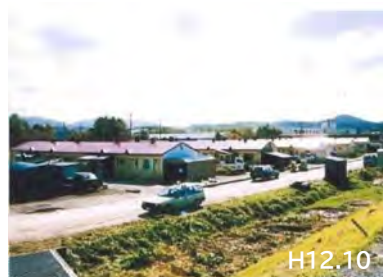
浸水被害箇所
