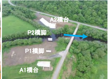
橋梁架替(一已内橋) (宗谷総合振興局)
