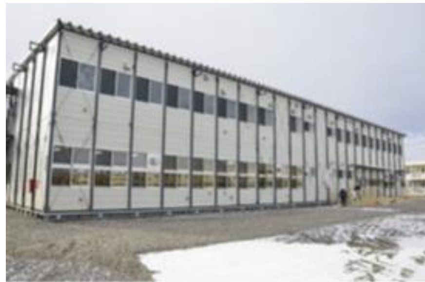
早来中学校仮設校舎(安平町)
