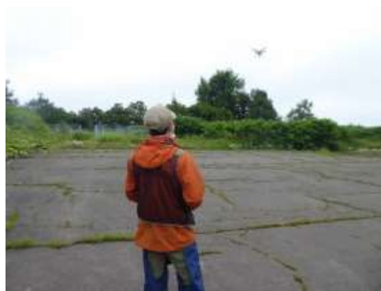
写真 5-1-4 ドローン調査 (7月14日紋別市)
