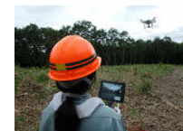
<UAVを活用した施行管理>
