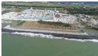
海岸防災林造成 (むかわ町)
