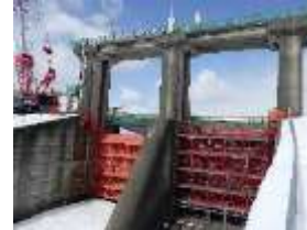
幌別ダム改修工事 (登別市)
