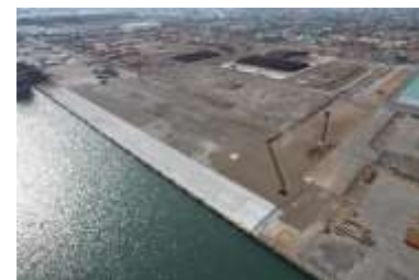
苫小牧港中央北ふ頭整備状況
