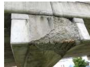
橋梁の老朽化対策箇所
