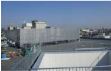
災害拠点病院自家発電施設整備 （北海道医療センター）
