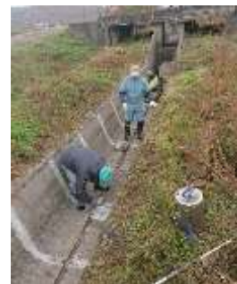
水路の目地補修
