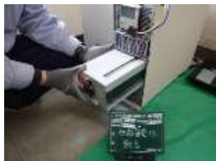
蓄電池交換（根室振興局）
