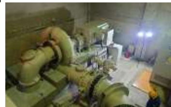
小水力発電設備の改良 (愛別ダム)
