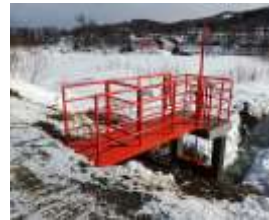
樋門の長寿命化 (仁木町)
