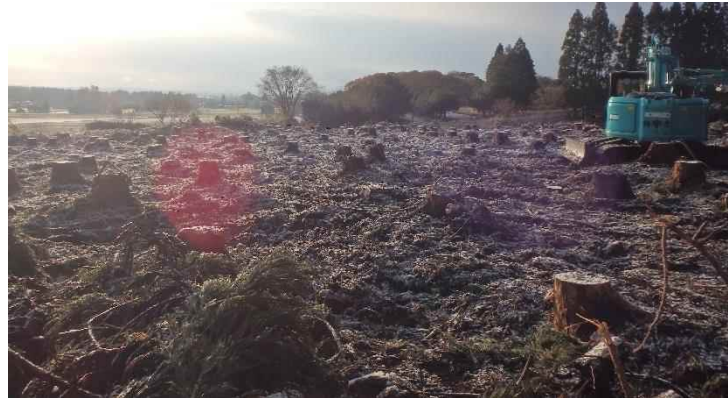
写真 3-23 地拵え後の実証地
