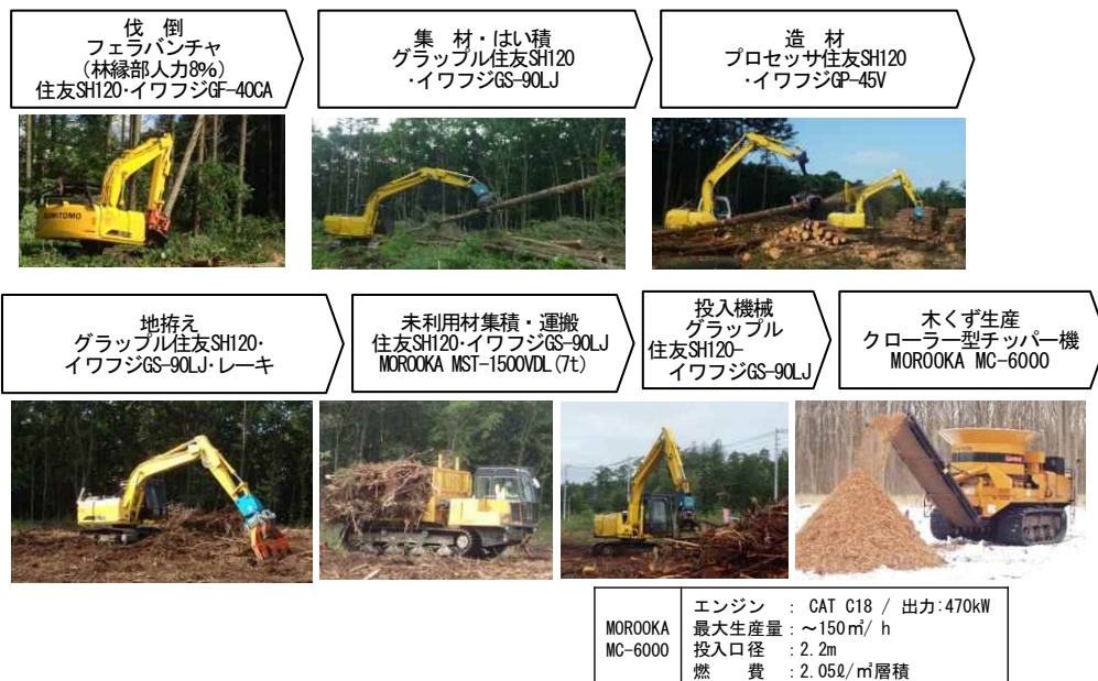
図 3-5 道央地区（安平町）における作業システム
