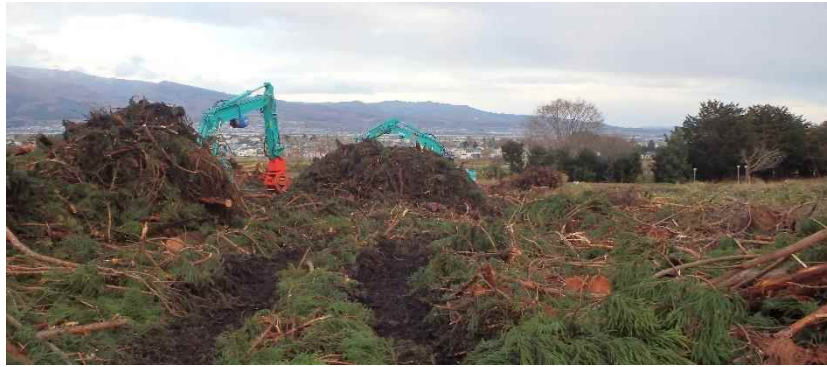
写真 3-22 未利用材の集積ライン両側への小分け集積
