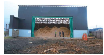
チップ保管庫は、冬でも雪でチップが濡れないために設置した。
