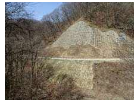
林道改良整備対策工完了
