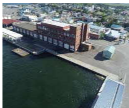
-3.5m岸壁着手前
