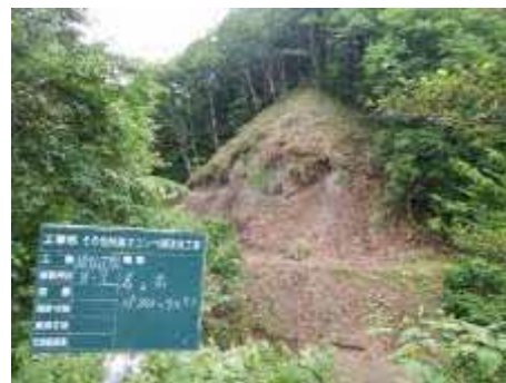
林道改良整備対策工着手前
