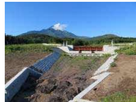
砂防堰堤工完了
