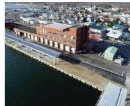
-3.5m岸壁完了
