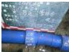
耐震管へ改修
