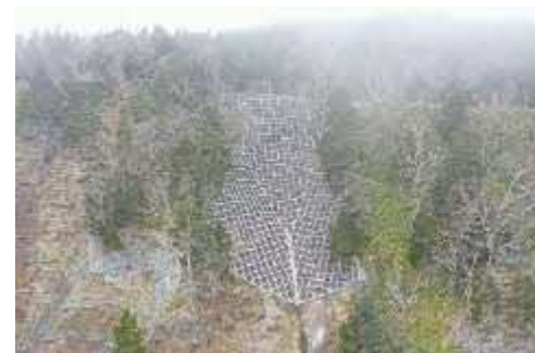
法枠工による斜面对策完了
