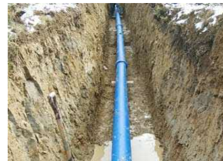
整備後(耐震化された管路)
