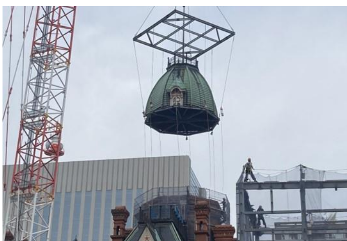
八角塔屋根の移設（令和4年8月）
