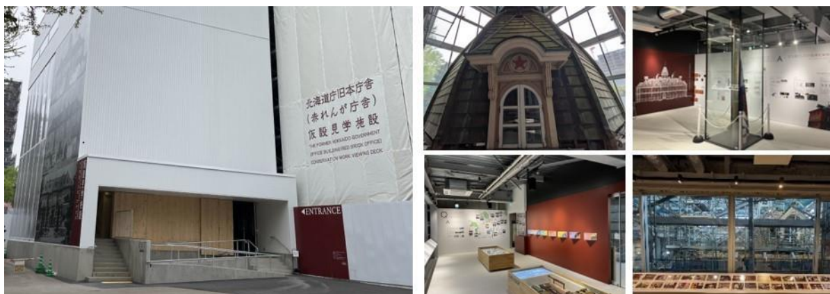
仮設見学施設の外観と内部の様子
