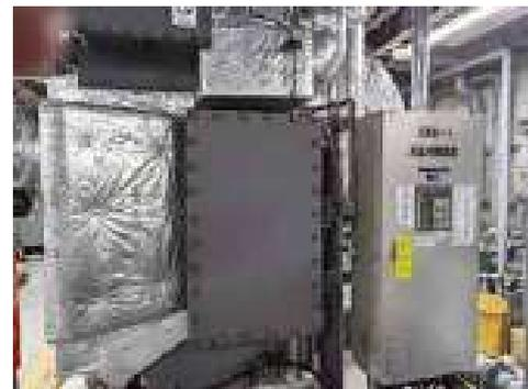
LNG式冷温水発生機
