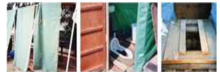
左：支援物資のトイレが側に白くまきサーカークールとフロアシートで作ったトイレ 中：資材を繋いで作ったトイレ 右：マンホールの上に資材を繋いで作ったトイレ
