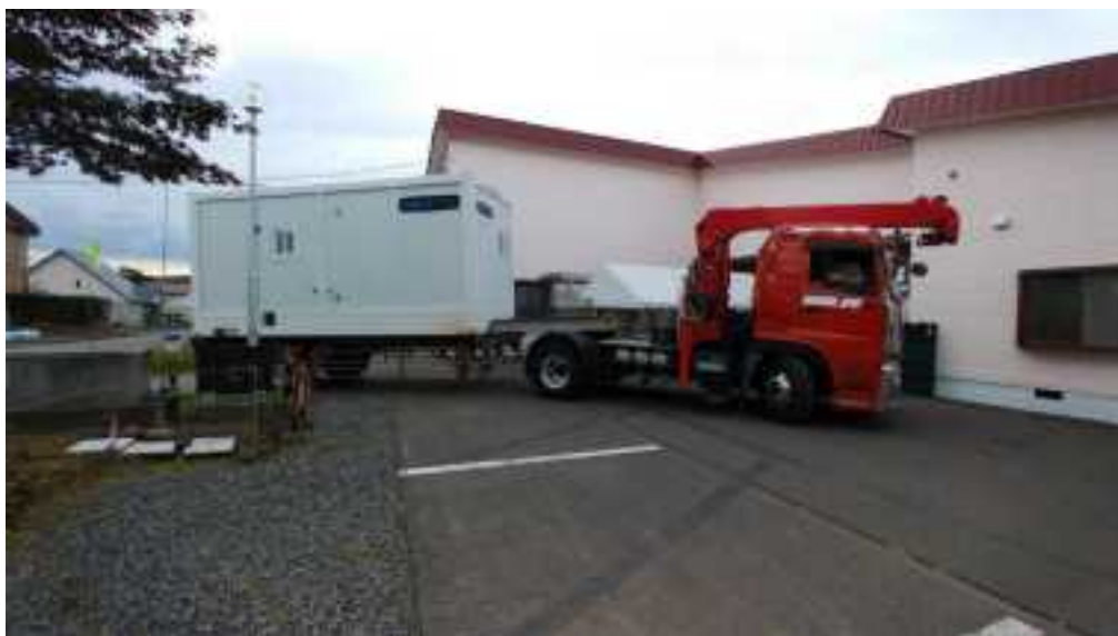
役場担当者に設置避難所を確認し現地到着
