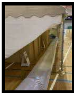
【屋外ダクトヒーター】 屋内テント内へのビニール ダクト設置
