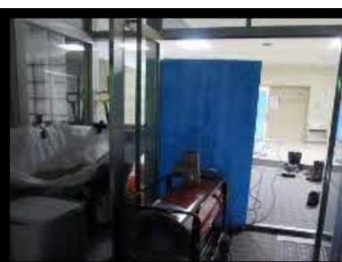
【屋外ダクトヒーター】 屋外(体育館玄関)に設置
