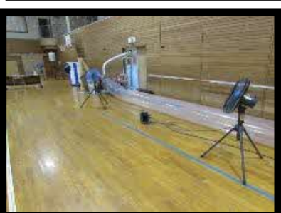
【屋内ダクトヒーター】 【ビニールダクト】 【業務用送風機】
