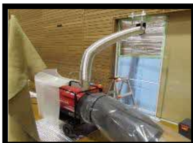
【屋内ダクトヒーター】 屋内(体育館内)に設置
