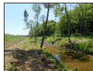
河道掘削、樹木伐採
