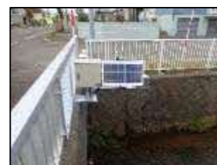
危機管理型水位計 (洪水時に特化した低コスト水位計)
