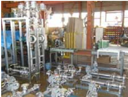
各種ユニット設計施工
