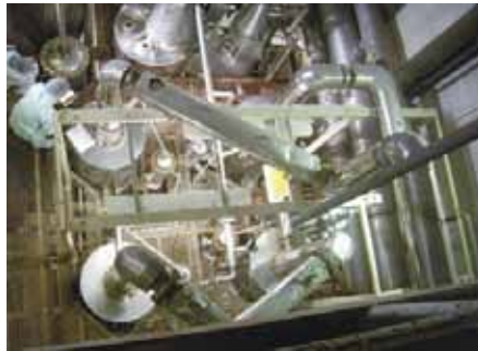
濃縮設備改修
