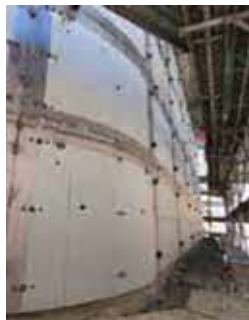
【橋脚補強板の複雑形状加工】
