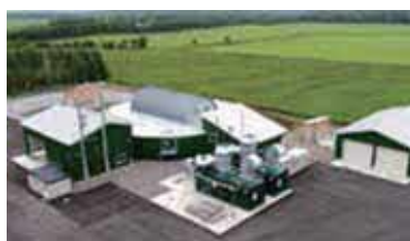
【バイオガス発電プラント】
