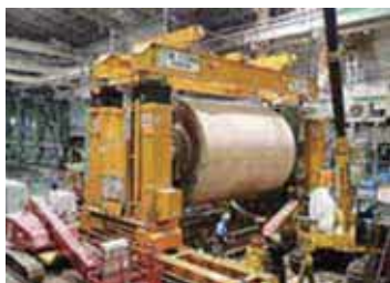
【機械据付、解体】
