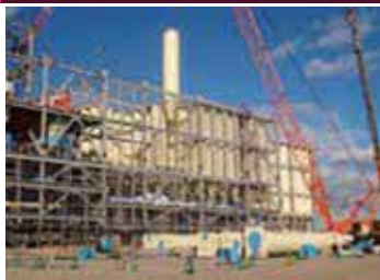
【ホクレンくみあい飼料殿 十勝工場新設工事】
