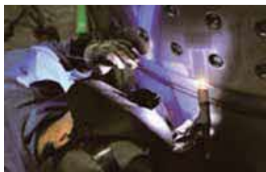
【タンクディンプルジャケット溶接】
