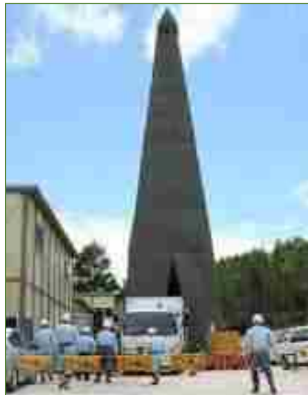
ボーリング調査 (HDB-11孔)
