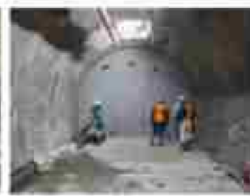
切り欠きの掘削とプラグの施工例
