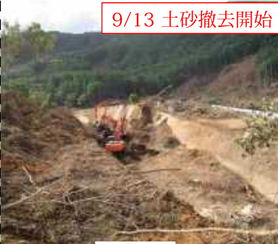
土砂撤去状況
