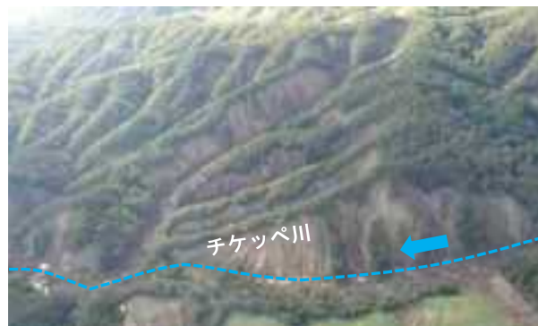
チケッペ川の山腹崩壊状況
