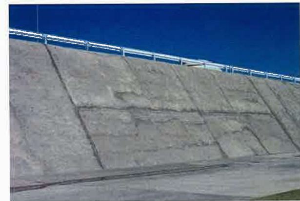
防潮堤(約1,000m)
