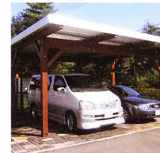
帯広市●カーポート 十勝産カラマツを強度のある集成材に加工して組み立てたカーポート。
