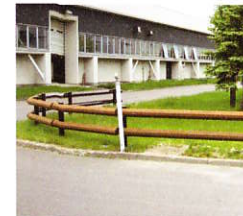
旭川市●木製ガードレール 景観と調和する優れた意匠を持ち、耐雪型でB種基準に合格した唯一の木製ガードレールです。
