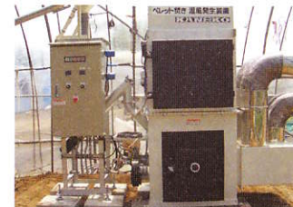
ペレットボイラー 農業用ビニールハウスの加温用。地域の木材から作った木質ペレットを使い、地域の農作物を作る。これも地材地消の取組といえます。
