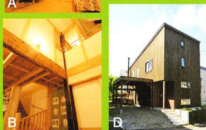
A B 札幌市厚別区のY邸。道産のカラマツやエゾマツ、古民家のヤチダモ材などを使用。リビングにはベレットと薪兼用のストーブを設置。
