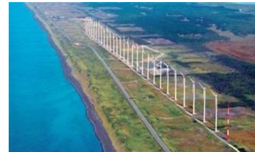
▲ オトノレイ風力発電所、幌延風力発電(株) (出典：NEDO)
