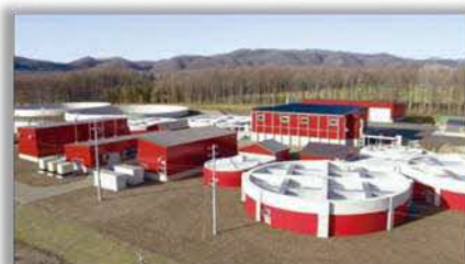
バイオガスプラント（鹿追町）
