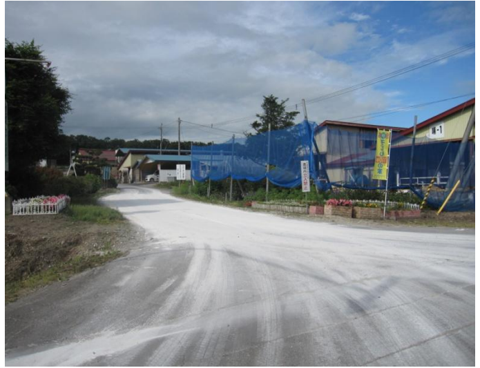
農場入口への消石灰の散布
