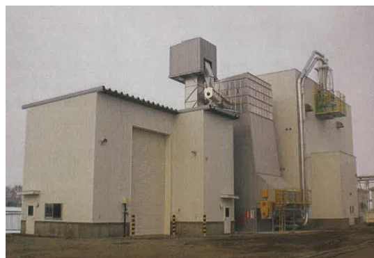
木質バイオマスボイラーの外観
