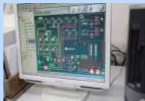
中央監視装置
