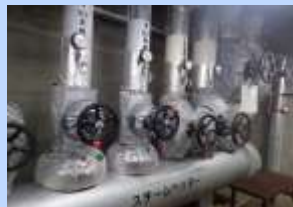
省エネジャケットで断熱対策
