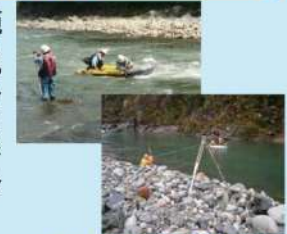
流量調査・測量作業
