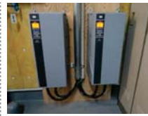
インバーター (熱源水ポンプ)
