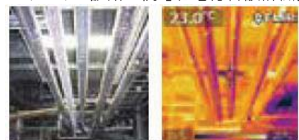
設備配管の熱漏れ箇所を可視化し、エネルギーロスの削減につなげます。
