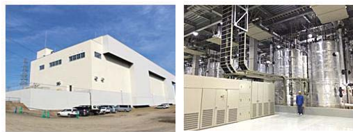
蓄電池建屋外観
