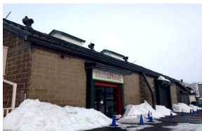
石造りの貯蔵倉庫を改装
