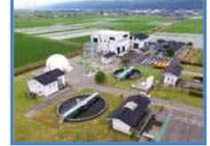
＜中能登町 バイオマスメタン発酵施設＞
