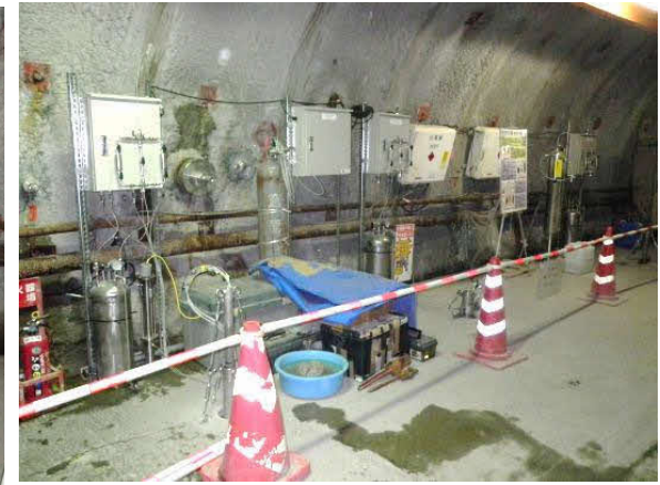
装置設置状況
