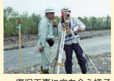
復旧工事に立ち会う様子
