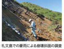
礼文島での豪雨による斜面崩壊の調査
