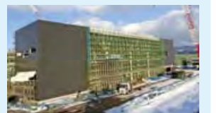
工事が進む新函館(仮称)駅(1月27日撮影)
