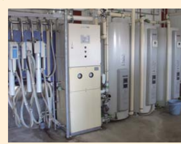
生乳温度を利用して省エネを可能にするミルクヒートポンプ
