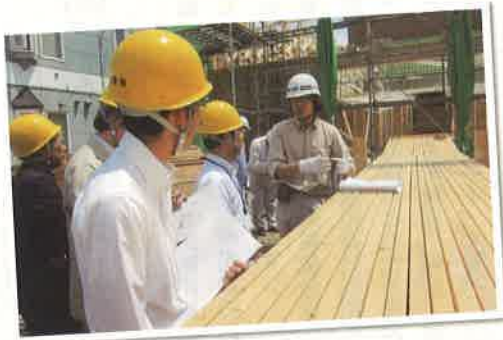
トドマツ2×4材トラスの実証試験施工状況見学会
