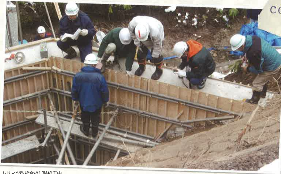
トドマツ型枠合板試験施工中
