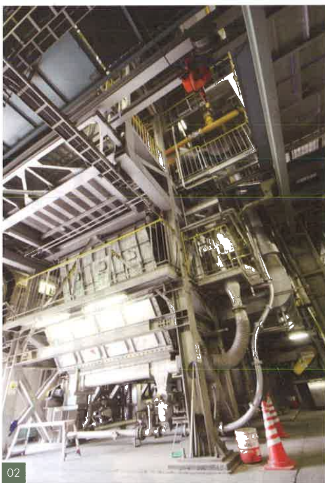
01 中央エネルギーセンター外観 02 林地未利用材等を燃料とするバイオマスボイラー
