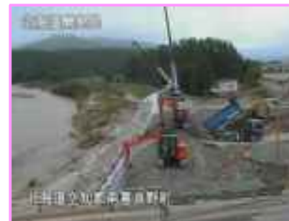
空知川堤防決壊箇所の復旧を監視 (南富良野町)※衛星通信車による画像
