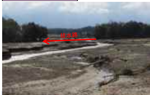
清水町：排水路の被災（排水路・農地の消失）
