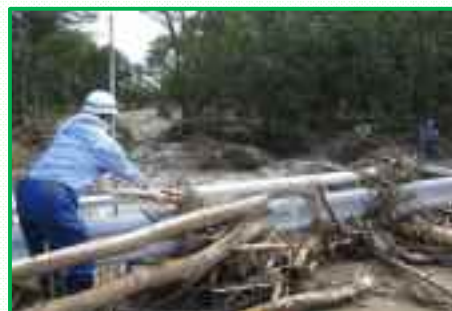
小林川 流木堆積 (清水町)
