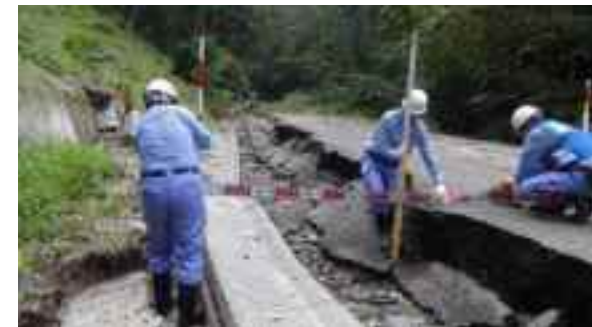
関東地整道路班 屈足地区現地調査(新得町)
