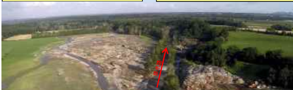
清水町：農地・排水路の被災（農地への土砂等の流入、護岸・法面の流失）
