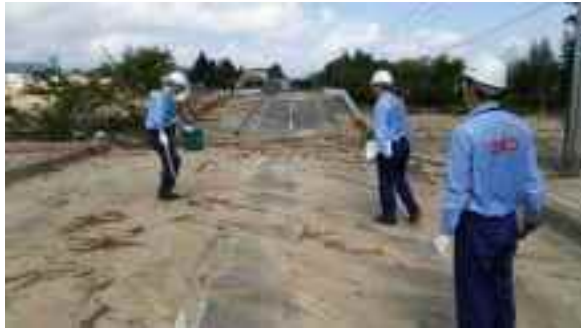
中国地整道路班 ペケレベツ川 橋梁調査(清水町)
