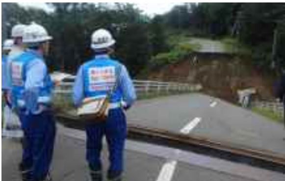
四国地整道路班 明星橋(岩内川)の調査(帯広市)
