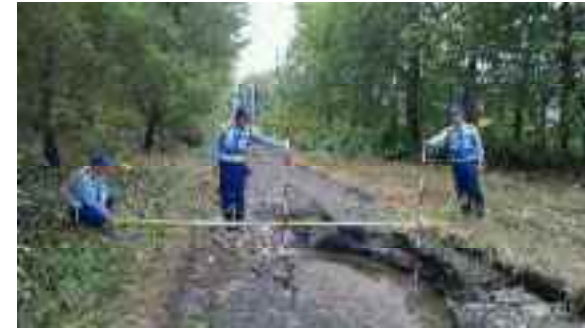
四国地整河川班 久山川沿い町道被災状況調査(清水町)
