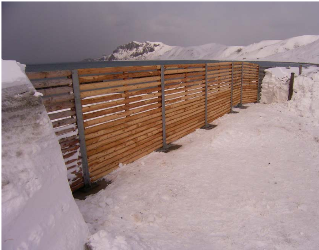
全景完成(防砂柵工)起点側→終点側
