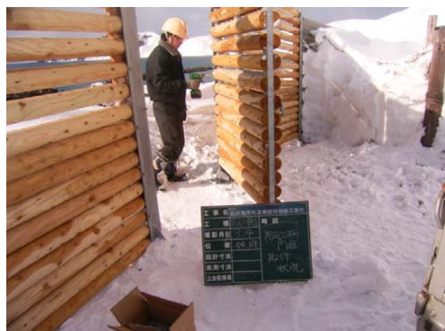
組立状況写真(防砂柵工)
