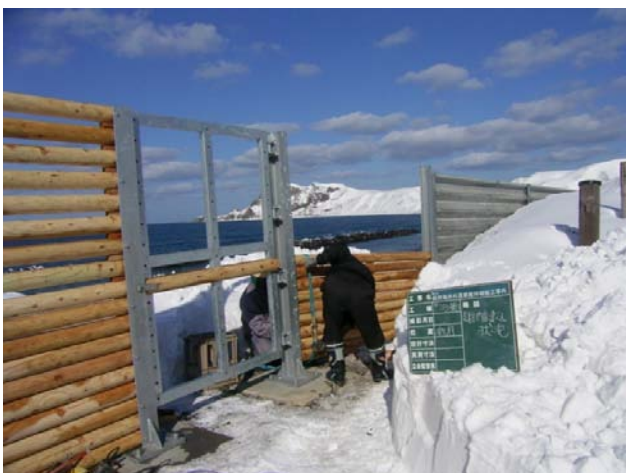
組立状況写真(防砂柵工)
