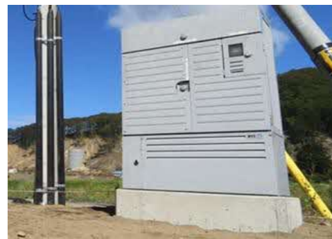
↑ 写真4 復旧後の通信設備
