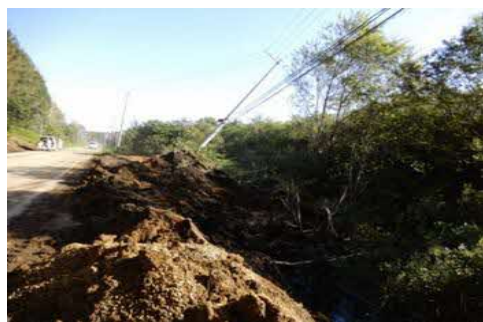
↑ 写真1 電柱の倒壊
