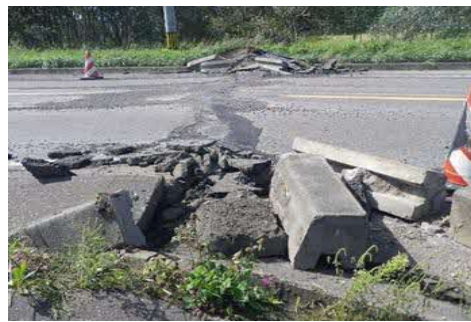
↑ 写真2 地下区間の被災
