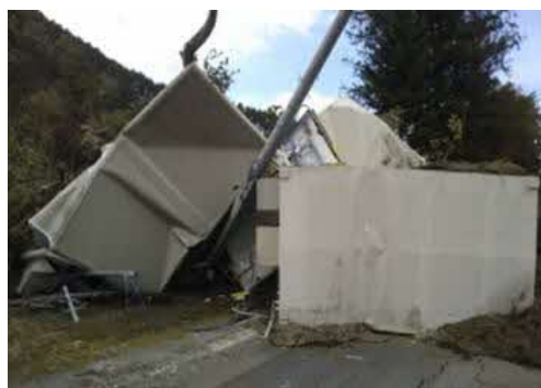
↑ 写真3 通信ビル倒壊
