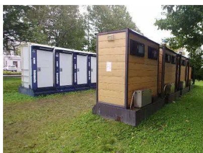
写真3-3-II-1 : 避難所開設2日後に到着した 仮設トイレの状況
