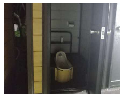
写真3-3-II-3 : 室内灯がない仮設トイレの状況
