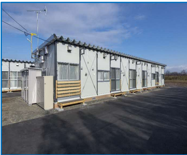
写真3-3-II-6：建設型応急仮設住宅
