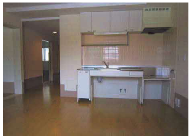
車いす使用者等に配慮し、下部を開放した流し台
