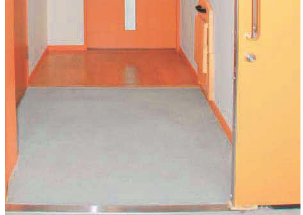
車いす等を考慮し、段差解消と広さを確保した玄関
