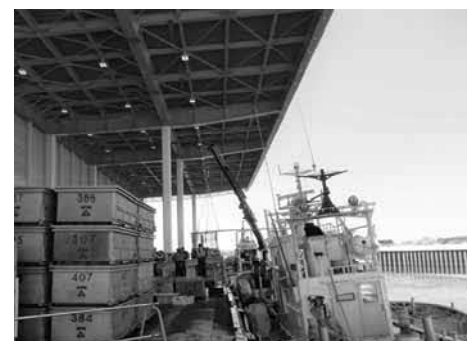
【衛生管理強化のため屋根付き岸壁を整備した漁港】
