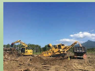
現地でチップ化して トラックで発電所へ運搬
