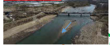
河道掘削整備状況
