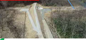
堤防整備状況
