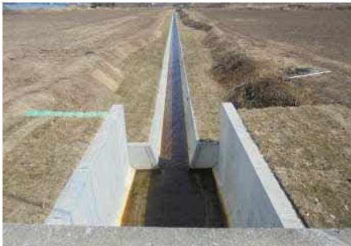
農業排水路の整備
