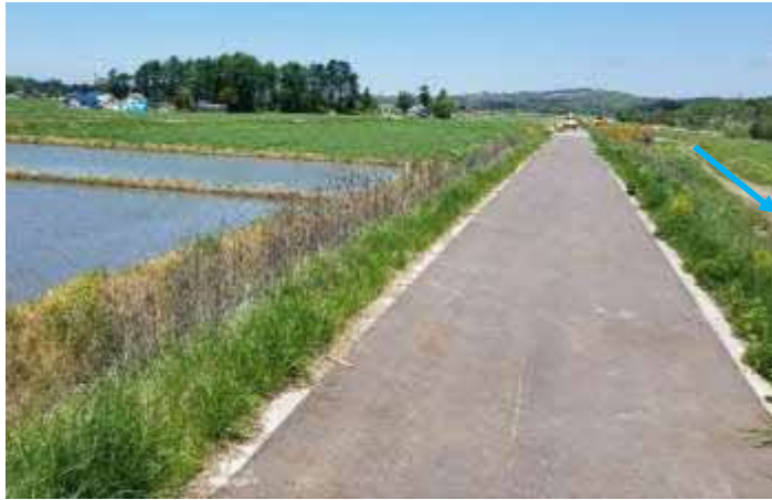
(安平川) 堤防天端舗装の実施
