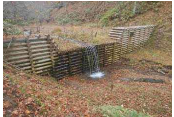
道有林内における治山ダムの整備
