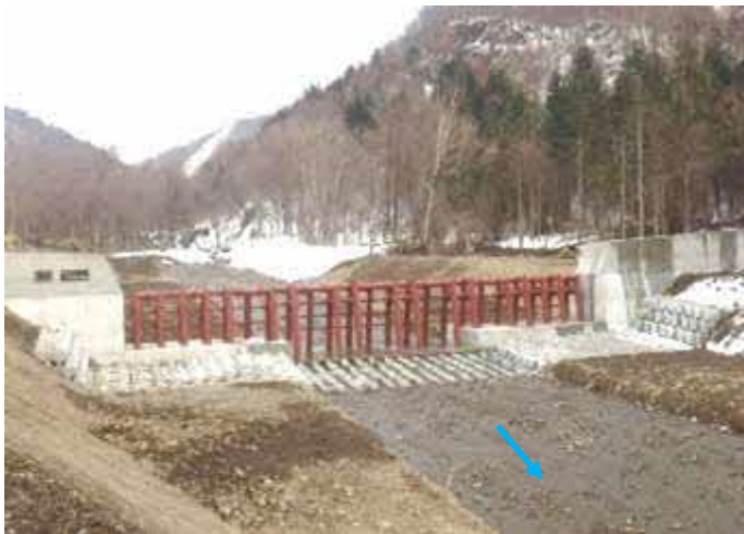
（紋別川）砂防堰堤の整備
